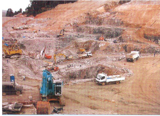
CÁC XE MÁY THI T B C A CÔNG TY ANG THI CÔNG TRÊN CÔNG TR NG TH Y I N SÊSAN 3
